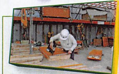
現場での作業に先立ち、加工場で型枠の加工や資材の用意などを行い、スムーズな現地工事に向か、準備万端整えます。
